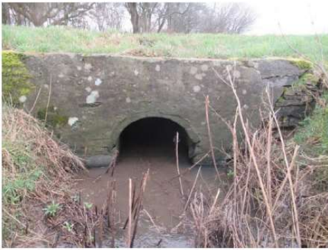
Facade mod øst. Kraftig forvitring af frontmur.
