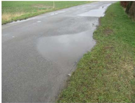
Lunker på OF vej i nordsiden.
