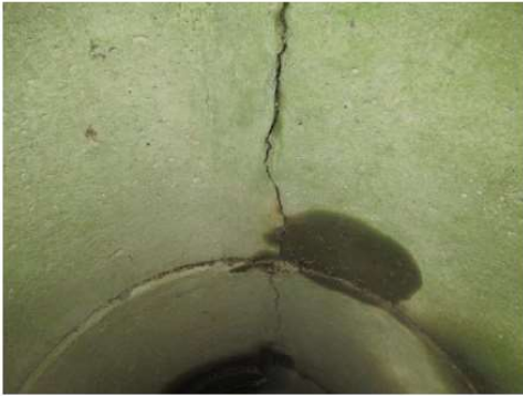
Grov revne i rør ved østlig facade.
